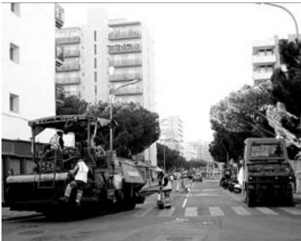
Avinguda de la Vila de Madrid, de Blanes, on uns operaris ja fan arranjaments pel pla de pavimentació ■ C.G.
